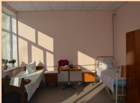
Капітальний ремонт амбулаторії ЗПСМ в с.Довгий Войнилів
